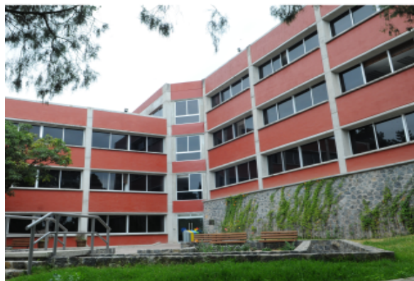
Figura 3.0.1 Edificio en donde se ubica el Laboratorio de Aplicación de las Matemáticas.
